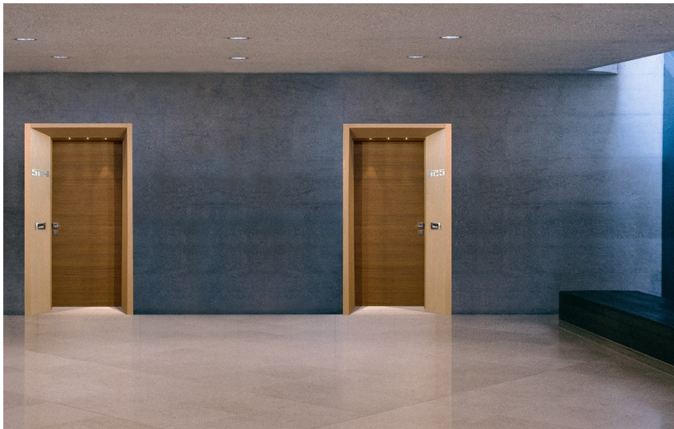
Porta tagliafuoco in legno con telaio inclinato per favorire la visibilità della numerazione delle camere ed illuminazione a led incassati / Fire rated door with inclined frame to help the visibility of the rooms numbering and with LED lighting
